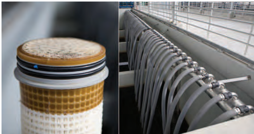
Water Factory 21- 326 ML/d (26 x Memcor ® CS608)
